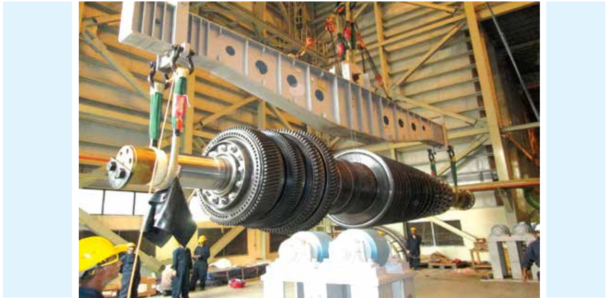
হরিপুর ৪১২ মেগাওয়াট কস্মাইন্ড সাইকেল বিদ্যুৎ কেন্দ্রের গ্যাস টারবাইন স্থাপন
